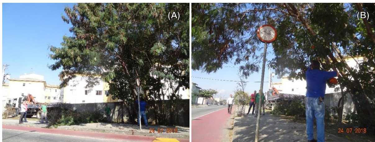
Figura 45 – Equipe da Secretaria Municipal de Meio Ambiente de Guaratinguetá/SP executando o serviço de poda de árvore.
