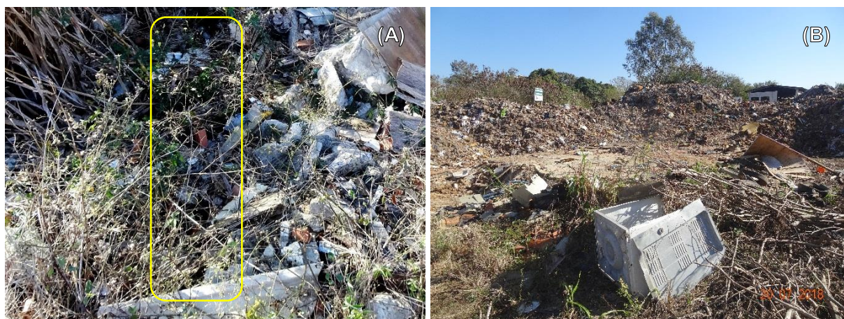
Figura 113 – Aspectos negativos da recuperação do antigo vazadouro à céu aberto: (A) Evidência de solo com rachaduras no talude do antigo vazadouro à céu aberto; (B) Armazenamento de resíduos sólidos inertes no local.
