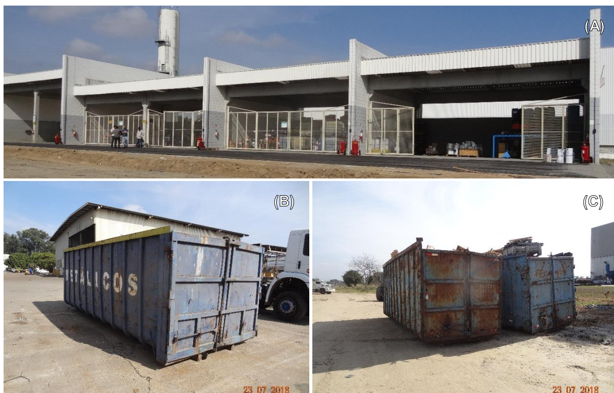
Figura 64 –Locais para o armazenamento externo de resíduos de uma indústria visitada em Guaratinguetá/SP: (A) Abrigo de resíduos geral; (B) Contêiner de sucatas metálicas; (C) Contêiner de madeiras.
