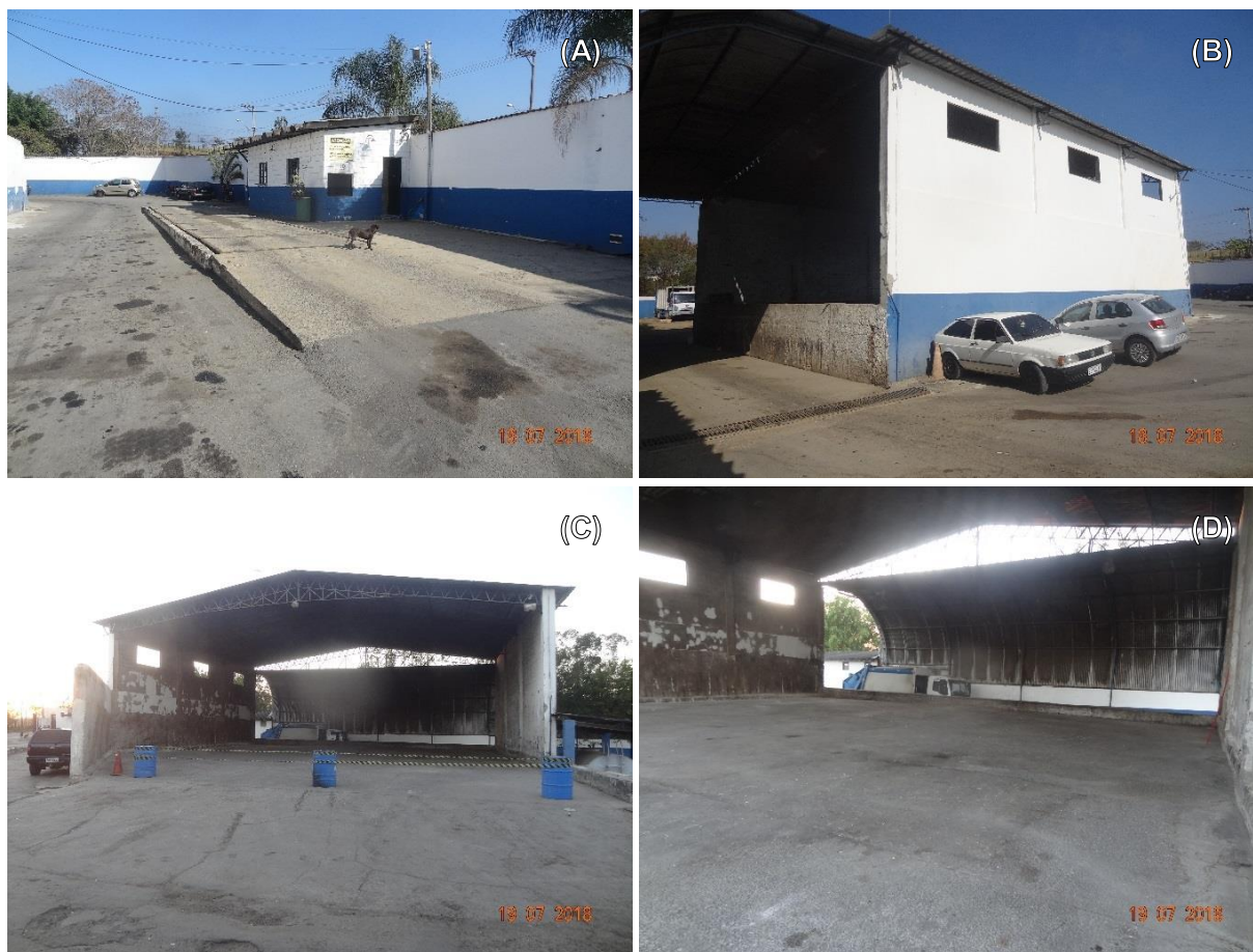
Figura 18 – Infraestrutura de transbordo de RSD, sendo (A) Balança de pesagem de veículos coletores; (B) Vista da área de carregamento de resíduos; (C) Vista da área de descarga de resíduos; e (D) Vista interna do pátio de transbordo.
