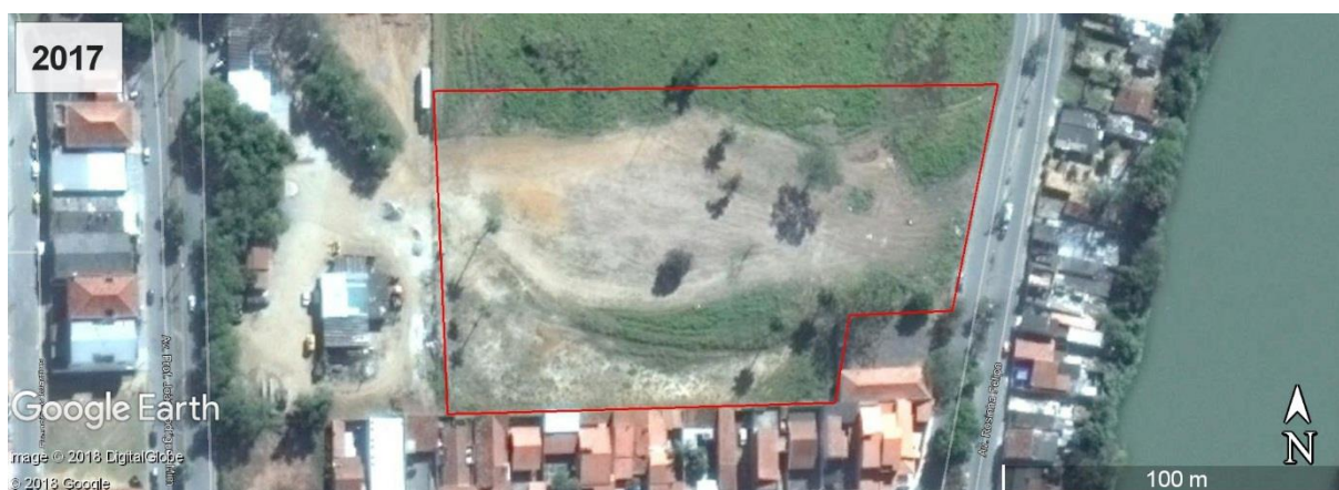
Figura 116 – Área da CODESG utilizada para armazenamento temporário de resíduos originados em suas atividades.
