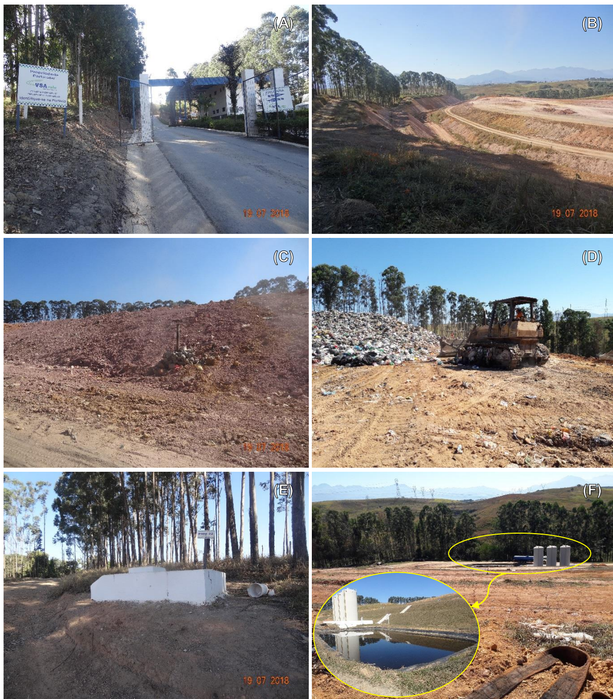
Figura 35 – Aterro sanitário da Vale Soluções Ambientais Ltda.: (A) Vista da portaria e área administrativa; (B) Vista do maciço de resíduos recoberto; (C) Flare; (D) Maquinário em operação; (E) Poço de monitoramento; (F) Vista do veículo sendo carregado de chorume para transporte ao tratamento, bem como da lagoa de chorume.
