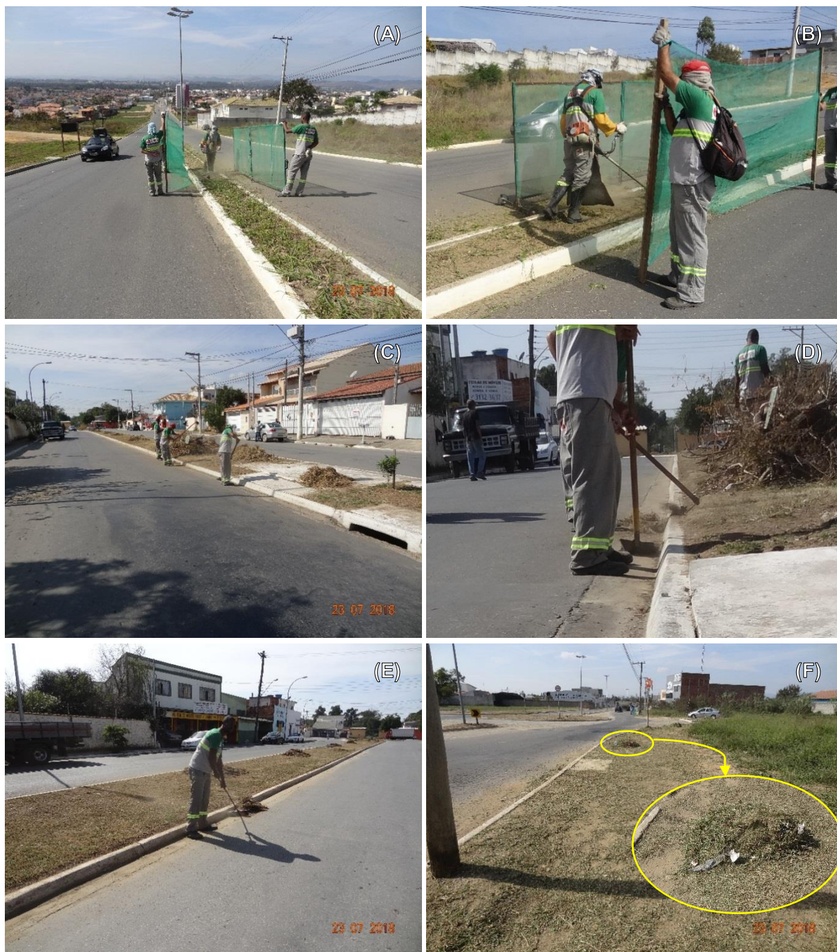
Figura 37 – Execução de alguns serviços de competência da CODESG: (A e B) Execução dos serviços de roçagem; (C) Visão geral da execução do serviço; (D) Capinação e raspagem; (E) Varrição da sarjeta; (F) Monte de resíduos de limpeza urbana pronto para a coleta.
