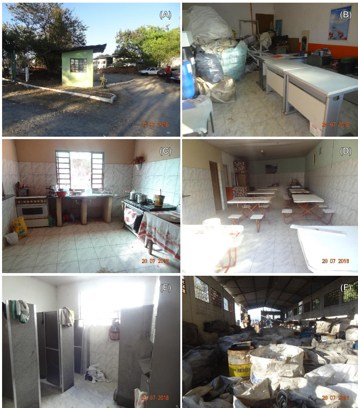
Figura 27 – Estrutura física da Cooperativa Amigos do Lixo de Guaratinguetá, sendo: (A) Guarita da Sede que encontra-se desativada; (B) Vista interna do escritório administrativo; (C) Cozinha; (D) Refeitório/copa; (E) Banheiro; e (F) Unidade de triagem de resíduos.
