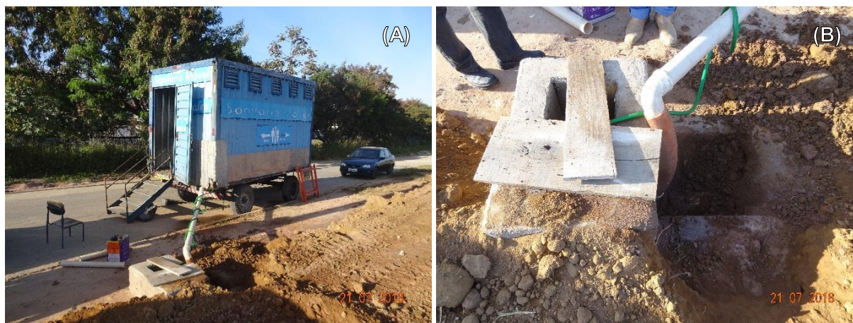
Figura 42 – Banheiro móvel utilizado nas feiras livres de Guaratinguetá/SP.
