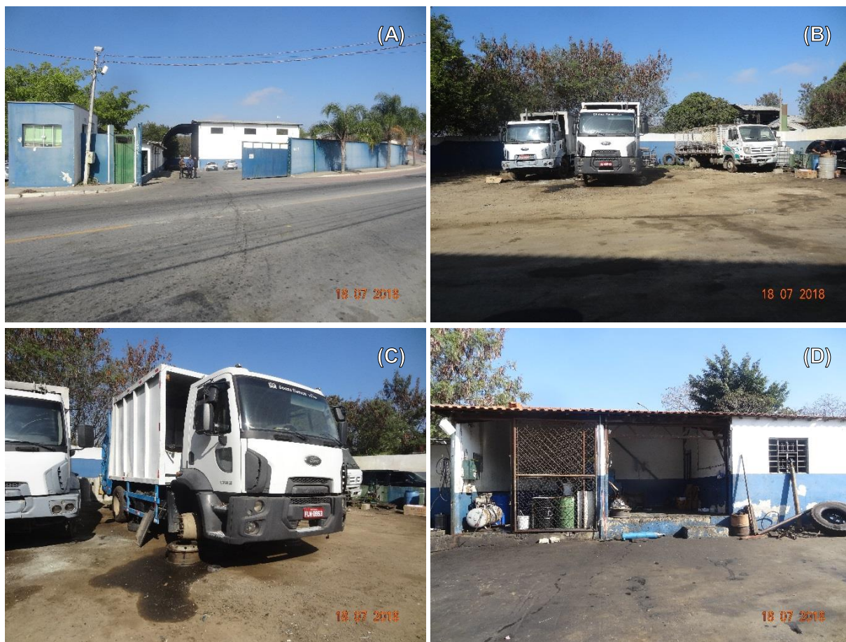
Figura 17 – Pátio para manutenção e garagem da CODESG, sendo: (A) Fachada do local que também abrange a estrutura física do transbordo de resíduos (desativado temporariamente); (B e C) Veículos coletores quebrados na garagem; e (D) Vista da oficina de manutenção básica dos veículos.
