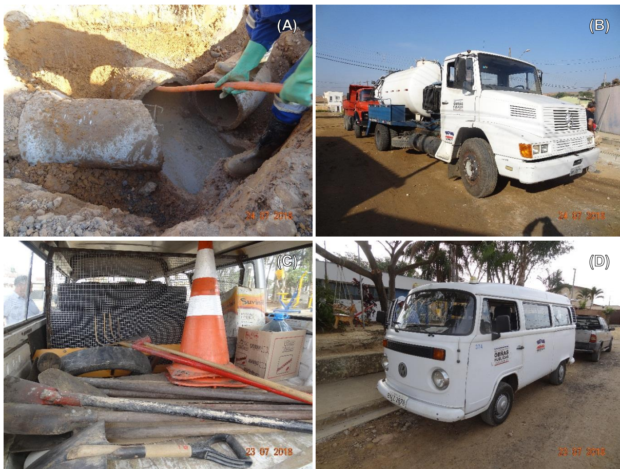
Figura 38 – Limpeza de boca de lobo no Jardim do Vale: (A) Execução das atividades de limpeza de sistema de drenagem de águas pluviais; (B) Caminhão Hidrojato; (C) Ferramentas utilizadas para a execução dos serviços; (D) Veículo utilizado para o transporte dos funcionários.
