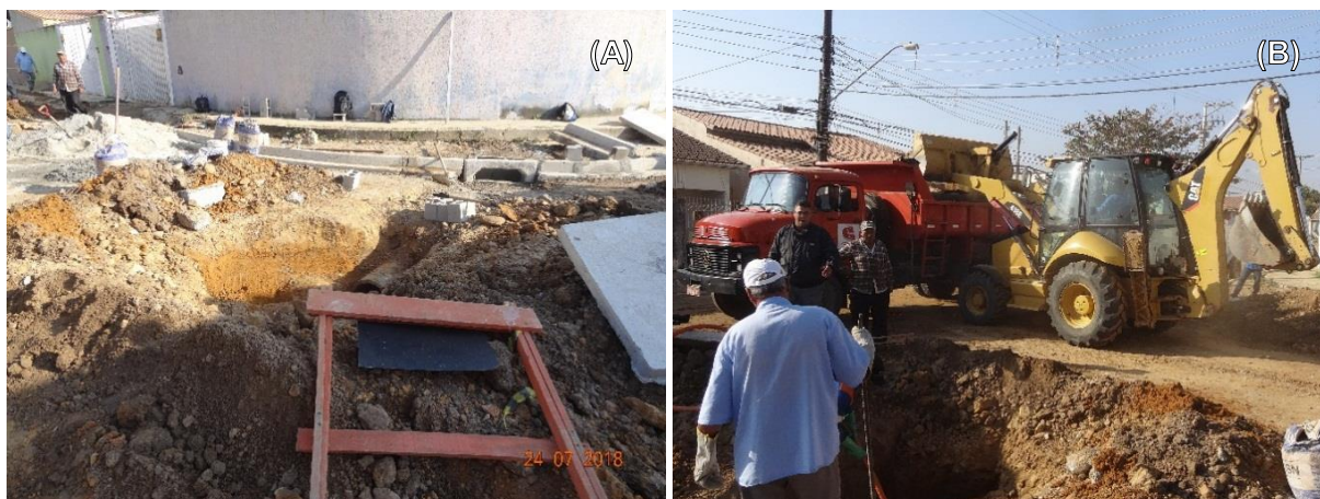
Figura 74 – Coleta e transporte de resíduos da construção civil: (A) Reforma de galerias pluviais no município de Guaratinguetá/SP; (B) Carregamento de caminhão basculante.
