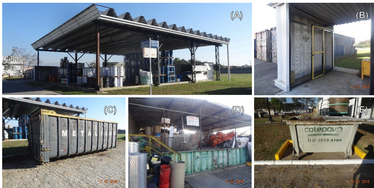
Figura 61 – Locais para o armazenamento de resíduos industriais em maior escala da Tekno: (A) Abrigo de resíduos perigosos; (B) Abrigo de resíduos de serviço de saúde; (C) Contêiner para abrigo de sucatas metálicas; (D) Abrigo de resíduos para reciclagem; (E) Caçamba estacionária para armazenamento de rejeitos.
