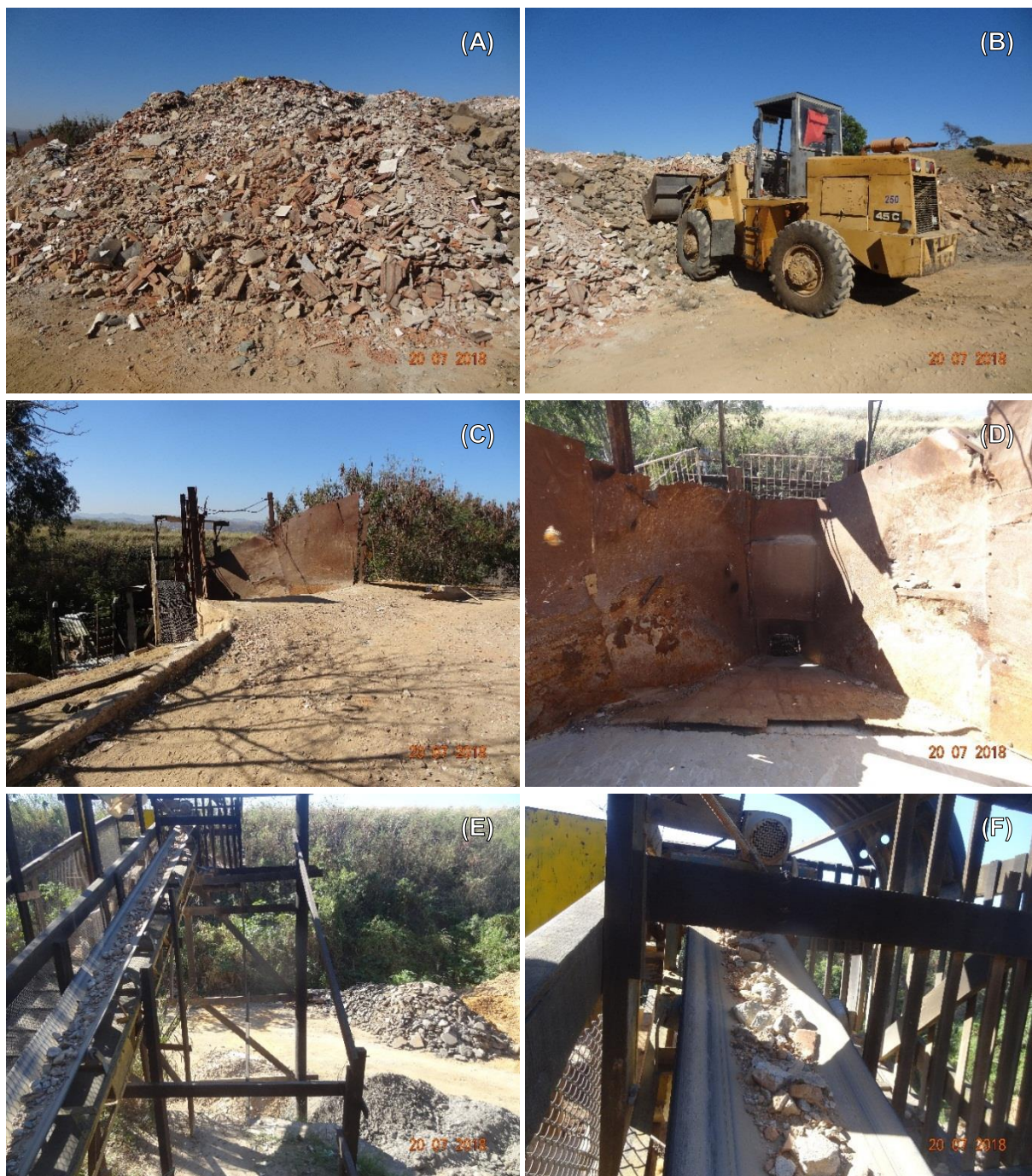
Figura 75 – Triturador de resíduos da construção civil (RCC) do município de Guaratinguetá/SP: (A) Resíduos da construção civil antes do processamento; (B) Máquina que transporta os resíduos para o funil do triturador; (C) Acesso ao funil do triturador; (D) Funil do triturador de RCC; (E) Rampa dos RCC triturados; (F) Resultado da trituração dos RCC.
