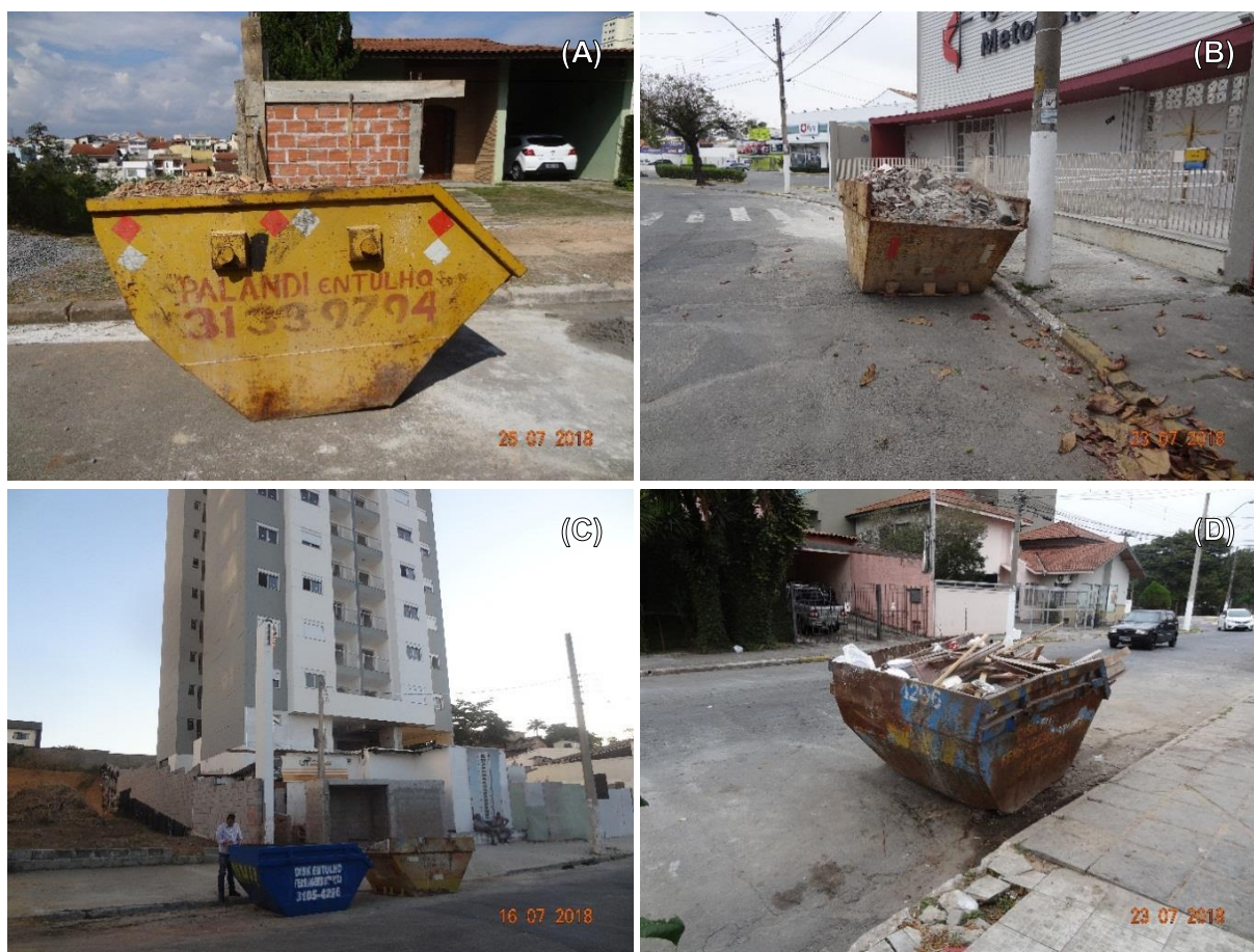
Figura 72 – Forma de acondicionamento de Resíduos da Construção Civil no município de Guaratinguetá/SP: (A) Caçamba estática devidamente alocada e sinalizada; (B, C e D) Caçambas estáticas de coleta de entulho observadas.
